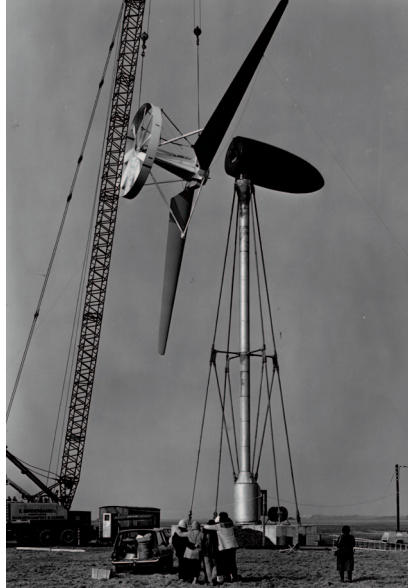
Tvind's PTG-mølle (Foto: Foto: Tvindkraft). Kuriant-mølle (Foto: Benny Christensen, DVS). Montage af rotor på Vølunds 265 kW mølle (Foto: Energimuseet). 300 kW DWT-møller ved Lynæs. (Foto: Flemming Hagensen)
