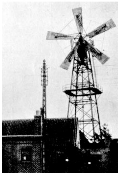
5-vinget "Agricco"-mølle i drift på Åkirkeby Elektricitetsværk 1922-27. (Foto i Statens Redskabsprøvers 36. beretning - 1925 - side 52)
