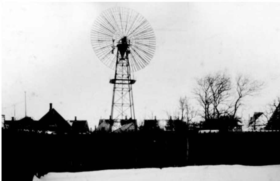
45-fods (14,1 m) vindrosemotor på Åkirkeby Elektricitetsværk (foto i Esbjerg Byhistoriske Arkiv) Samme billede er vist på side 75 i Werner Hansens bog "Fra det gamle Aakirkeby"- udgivet i anledning af byens 650-års jubilæum i 1996.
